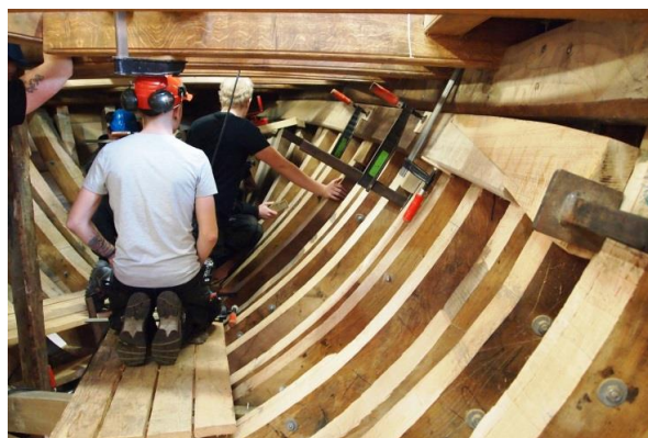
Planken presses på plads og fastgøres med spigre
