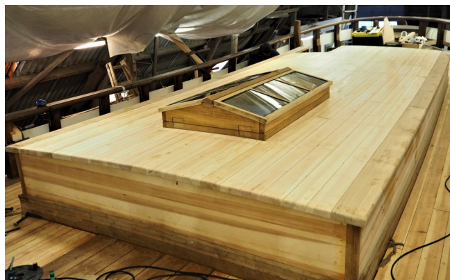
Ruftag med skyligt afsluttet
